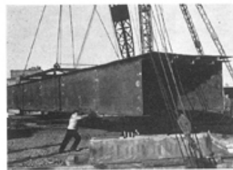
4 Entladen eines Kastenträgerabschnitts mit dem Derrick
