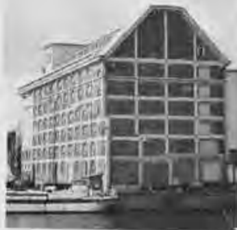
Was am Viktoriaspeicher am Spreeufer passiert, bewegt die Gemüter.
