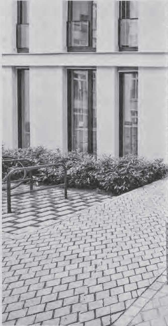
Neubauprojekt Choriner Höhe in Berlin. In-Mitte – 128 Eigentumswohnungen für gehobene Ansprüche, wie es heißt. Ein Paradies aber ist es nicht für alle.
