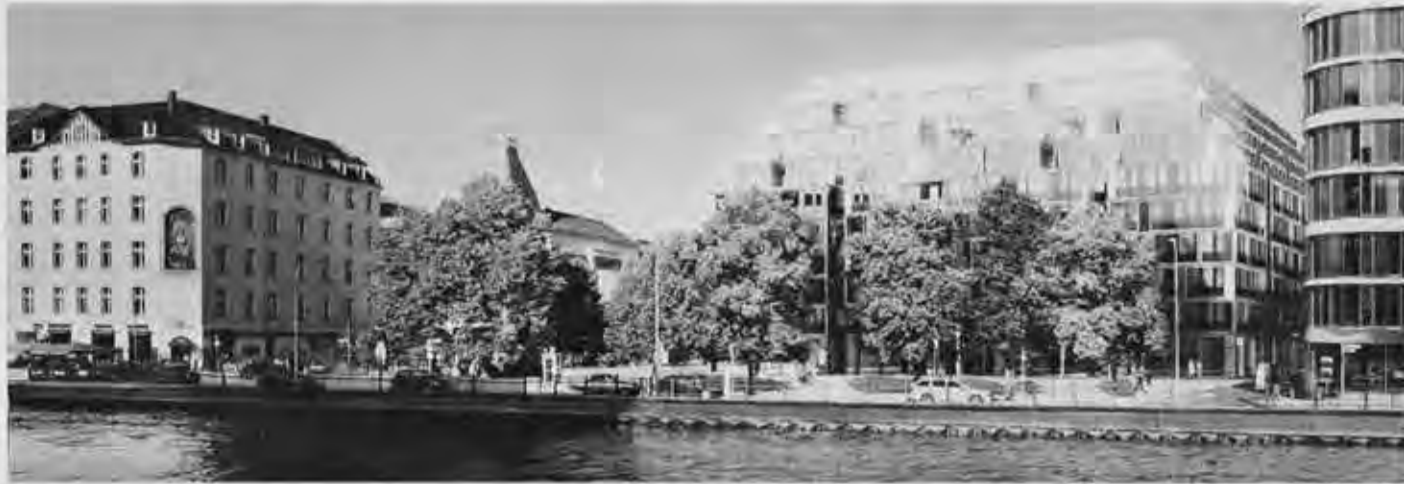
Blick auf die Spree – so soll der Neubau mit Luxuswohnungen aussehen. Der Investor gestaltet auch den Bertolt-Brecht-Platz um, die Bäume bleiben stehen.
